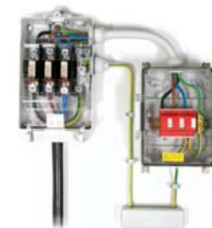
Blitzstrom-Ableiter schützen auch bei direktem Blitzeinschlag die Elektro-Installation
