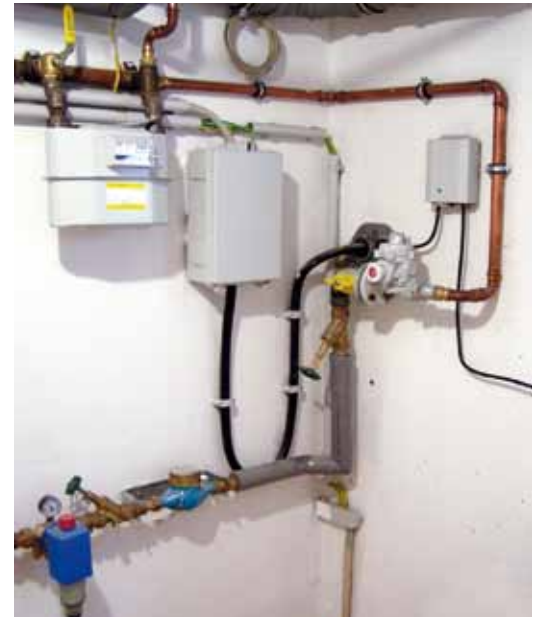
Beispiel einer Hausanschlusswand (oben)
