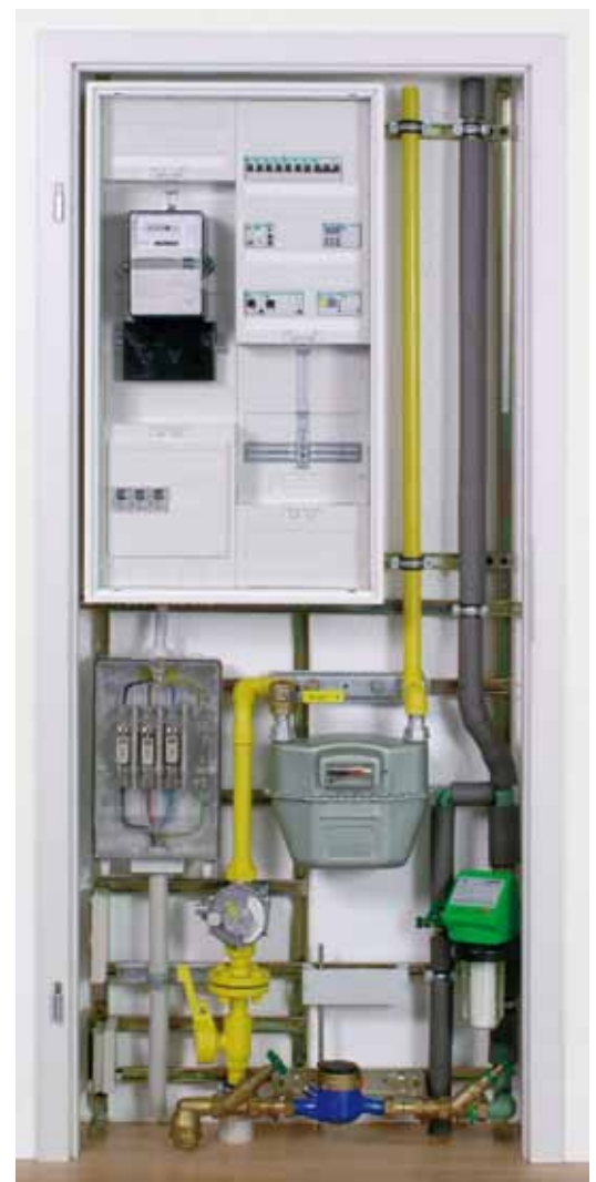
Beispiel einer Hausanschlussnische (unten)
